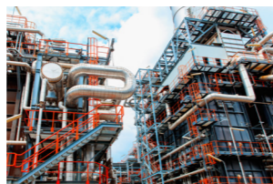
输气管道泄漏
